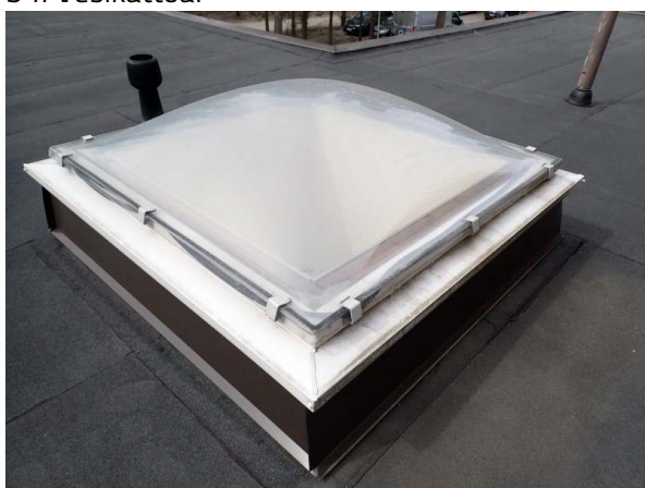
56. Kattokupu on uusittu
