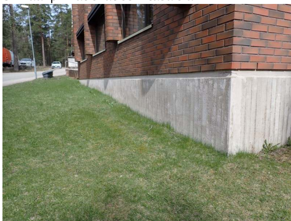
5. Humuspitoista maa-ainesta sokkelin vierellä
