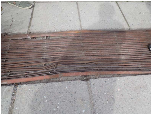
19. Ritilä on vääntynyt ja hieman vaarallinen asiakkaille mentäessä hammaslääkäriin.
