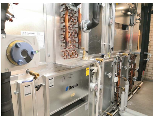
79. Ilmanvaihtokone TK201 on vuodelta 2012 mallia Recair.
