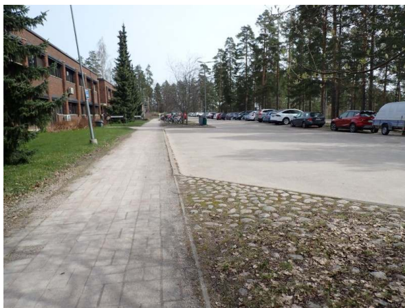
11. Kulkutiellä olevaa betonikivetystä
