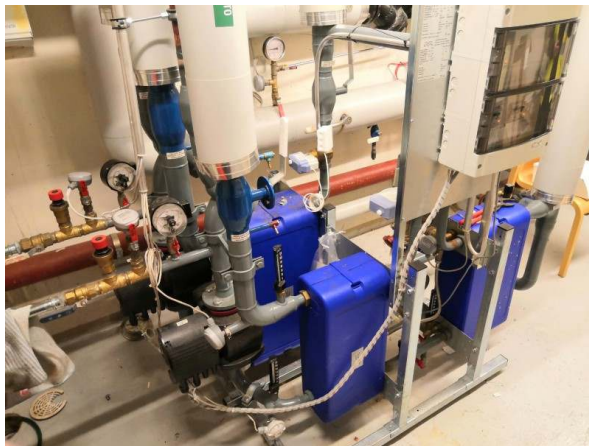
64. Lämmönjakokeskus.
