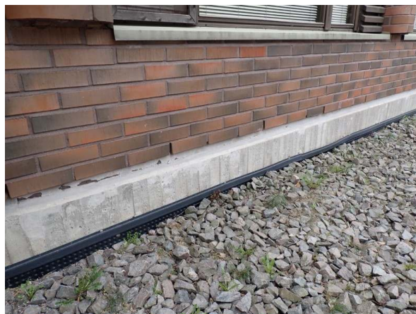
26. Perusmuurin vedeneristys on asennettu jälkikäteen
