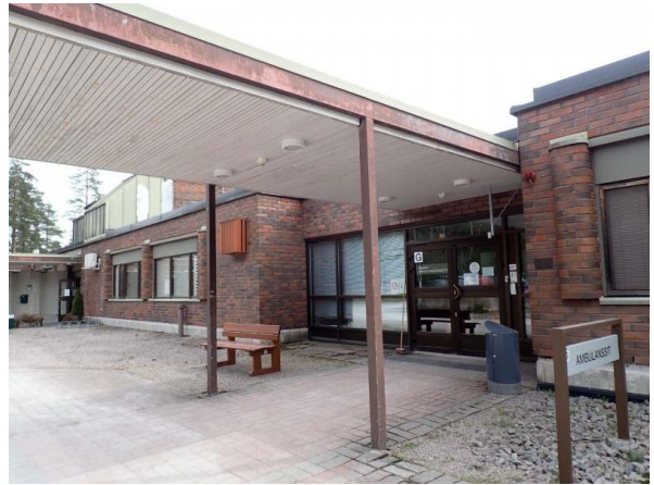
24. Katoksen maalipintojen kunnostaminen.
