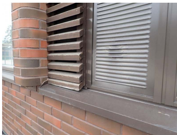
46. Puuritolöissä on kulumaa
