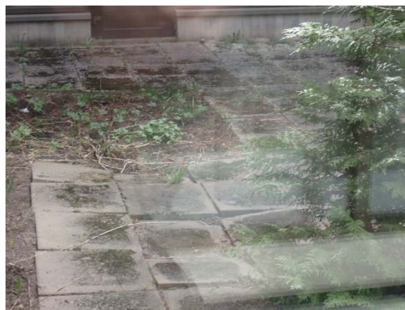
10. Sisäpihan laatoitukset ovat sammaleen peittämiä ja epätasaisia
